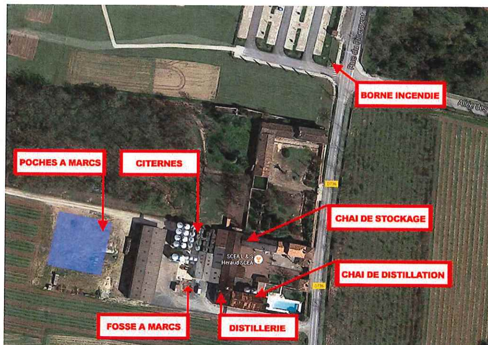
Vues aériennes du site
